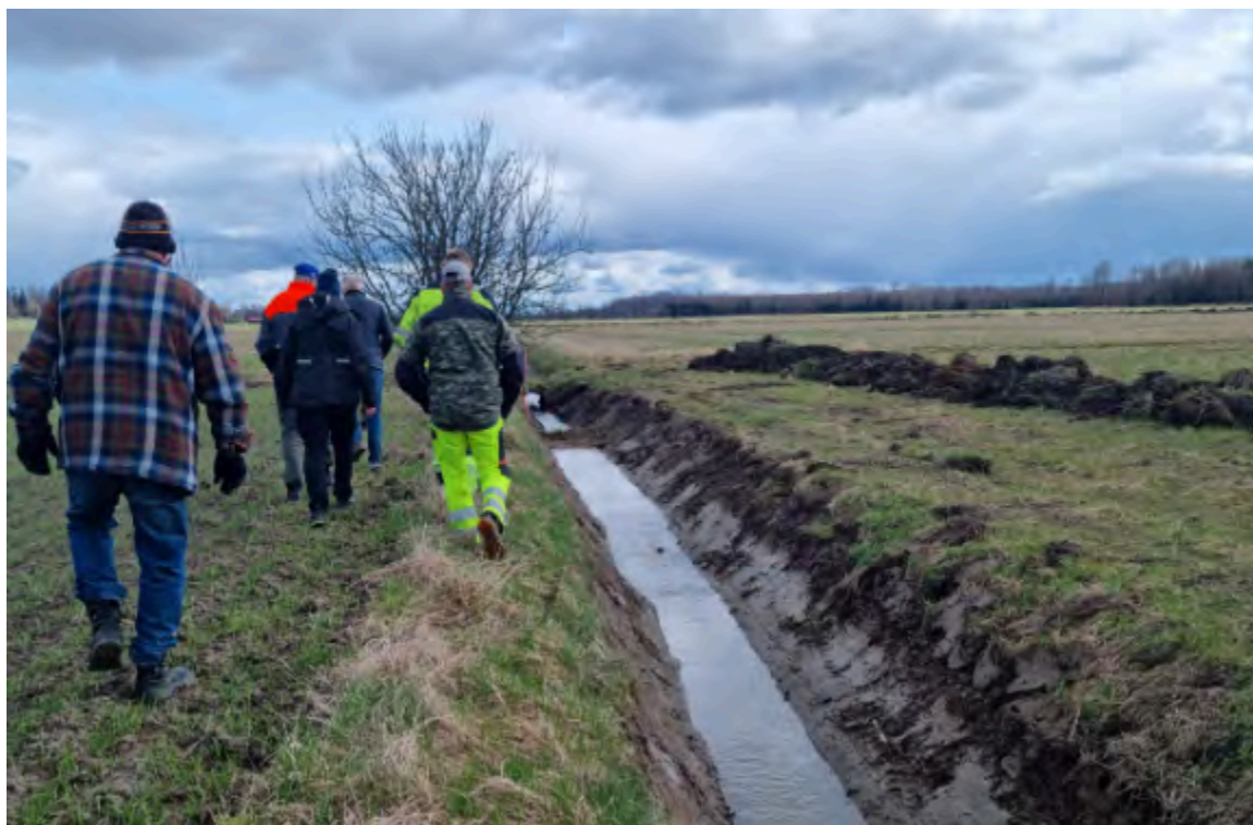
Figur 3: Rensning av dike i återupplivat dikningsföretag. Foto: Agneta Pettersson.
