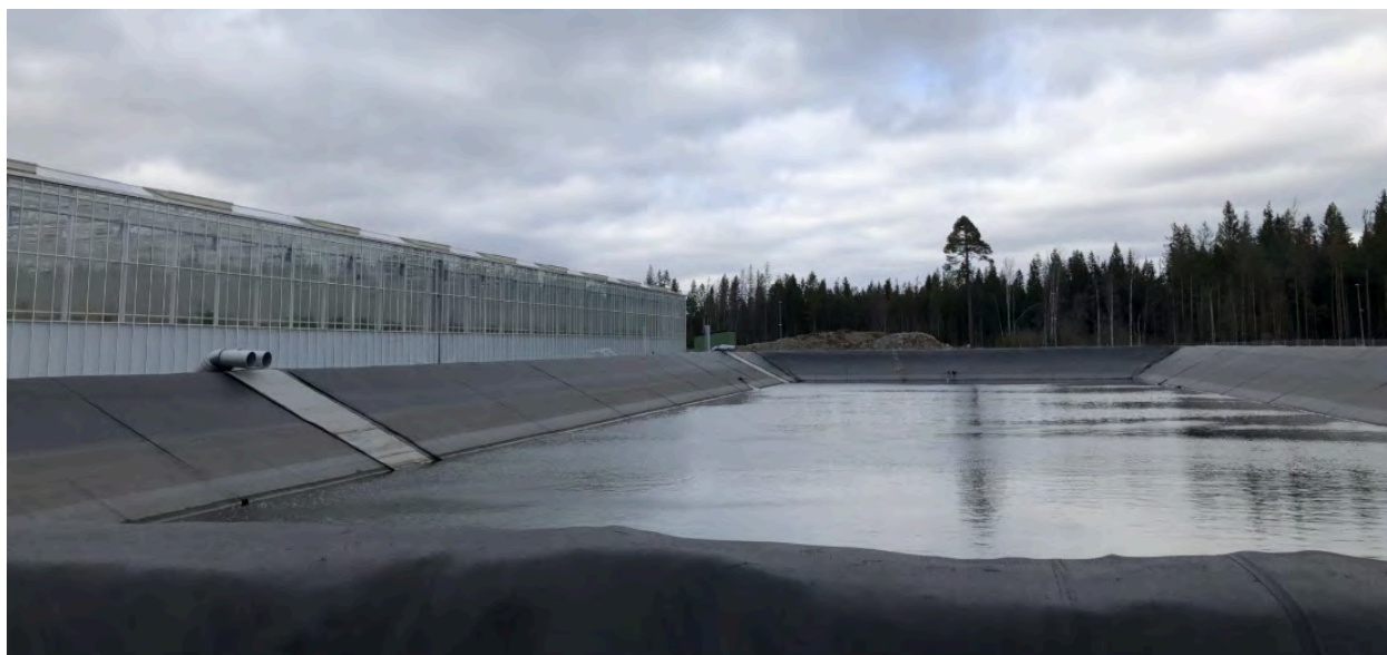
Figur 4: Bevattningsdammen utanför tomatodlingen i Frövi är ett exempel på hur man samlar upp regnvatten från växthustaken som sedan används för bevattning i odlingen. Foto: Malin Myhrberg
